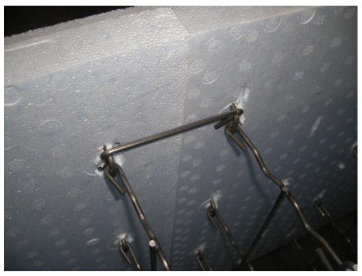
Image 2.13.b - Installation d'un crochet de joint.
